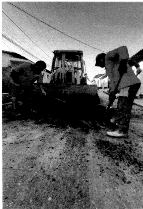
Serviços de Imprimação e Recapeamento Asfáltico.
