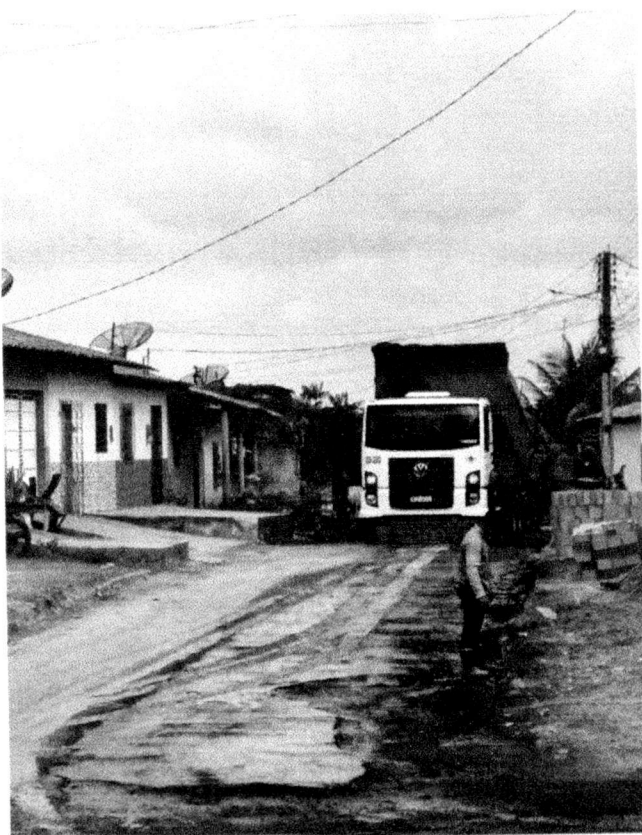
Serviços de reconformação e espalhamento de material asfáltico
